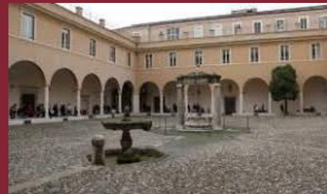
Vista del chiostro oggi
